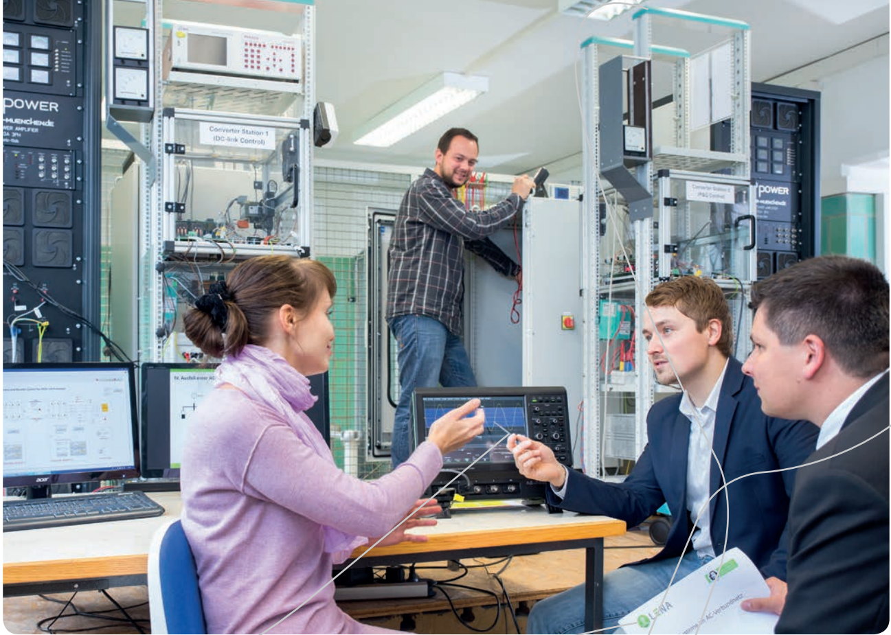
Aufbau und Inbetriebnahme des HGÜ Teststandes Foto: Stefan Berger
